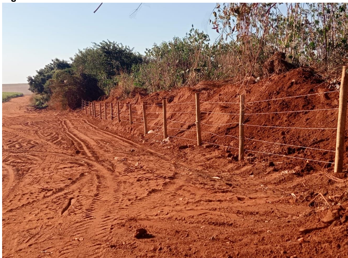
Figura 27: área do aterro sanitário será encerrado no ano 2026 local todo cercado lindeiro Estrada Municipal.
