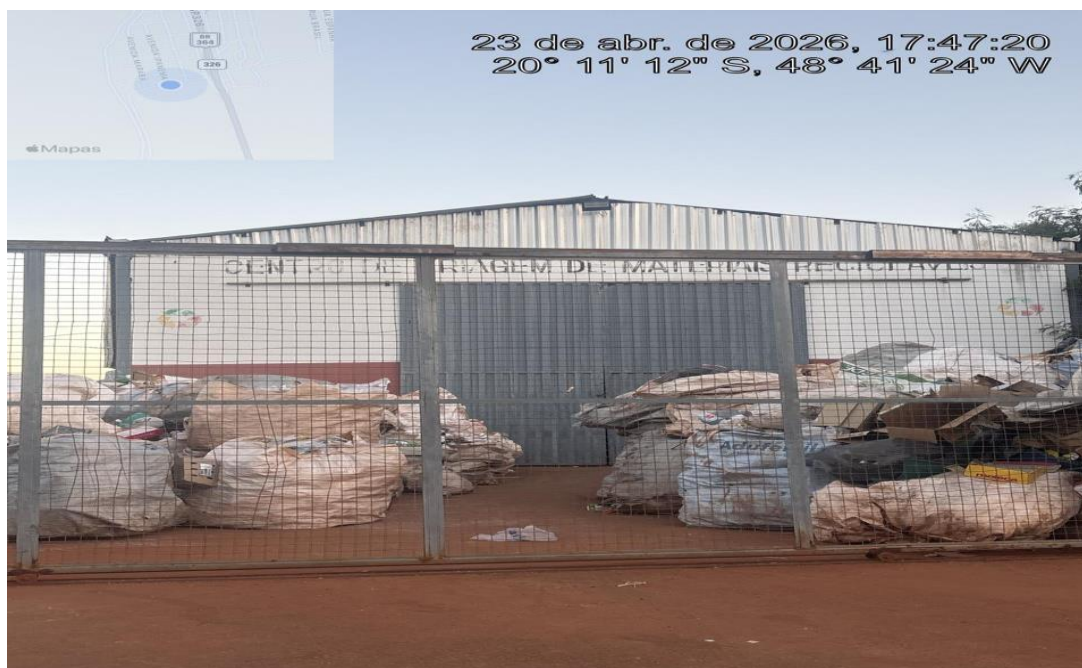
Figura 45: Galpão do Centro Triagem de Material Reciclado localizado na Rua Jose de Matos Romão número 263 bairro Vila Pirajá coordenado pela Cooperativa Coopercolômbia na área urbana e zona rural do Município de Colômbia-SP.
