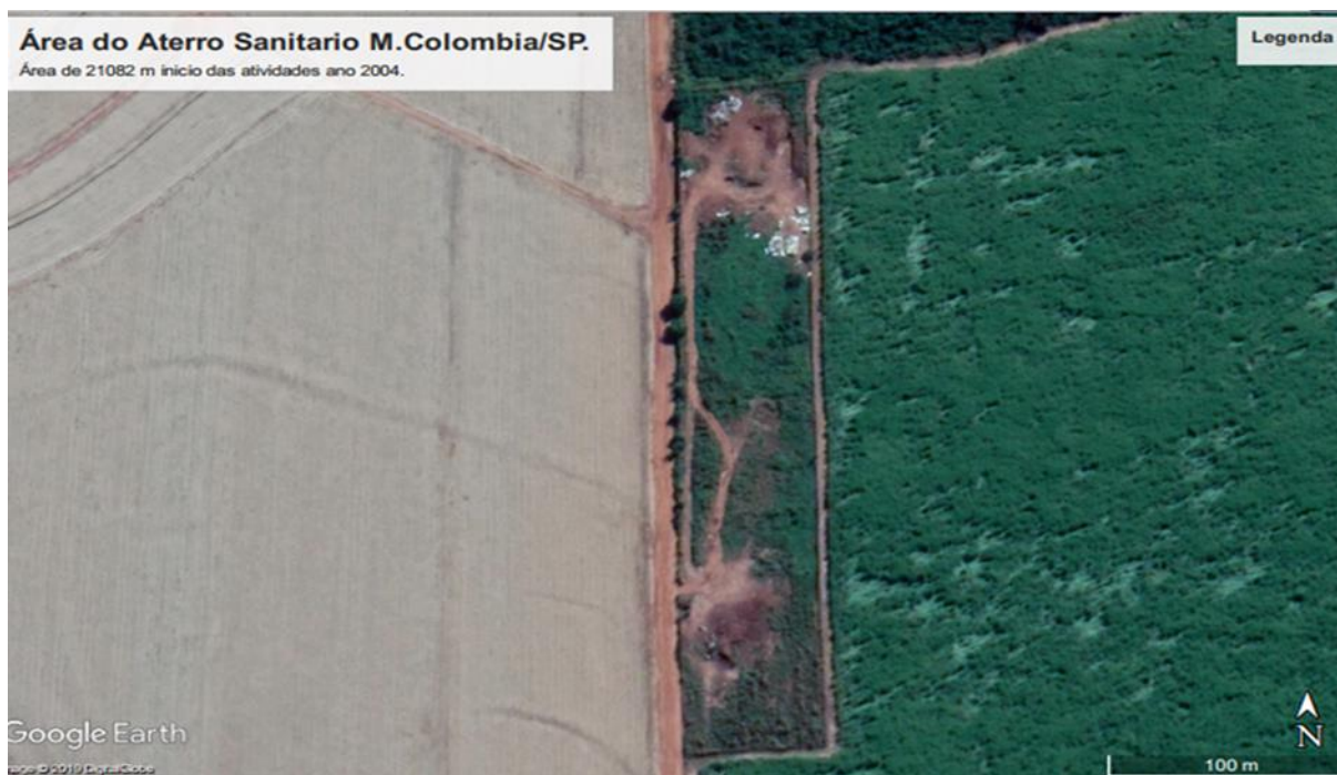
Figura 24 :Área do Sanitário em valas será desativado no Município de Colômbia/SP.
