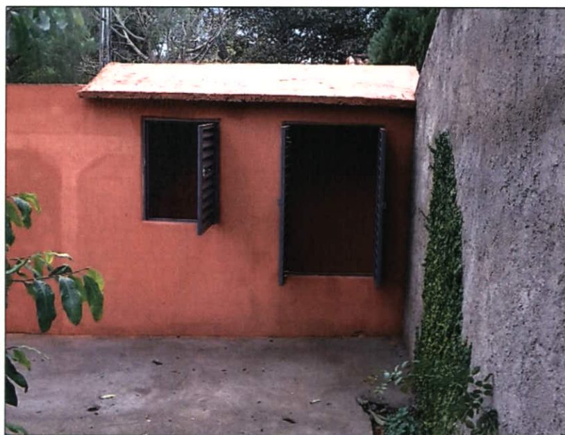
Figura 12 - Nicho para QEC e Medição (Recalque Esgoto bacia 02) - Laranjeiras
