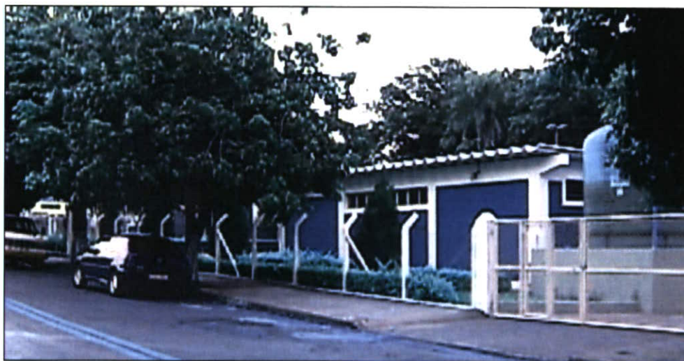
Foto 4 - Vista da fachada do escritório
