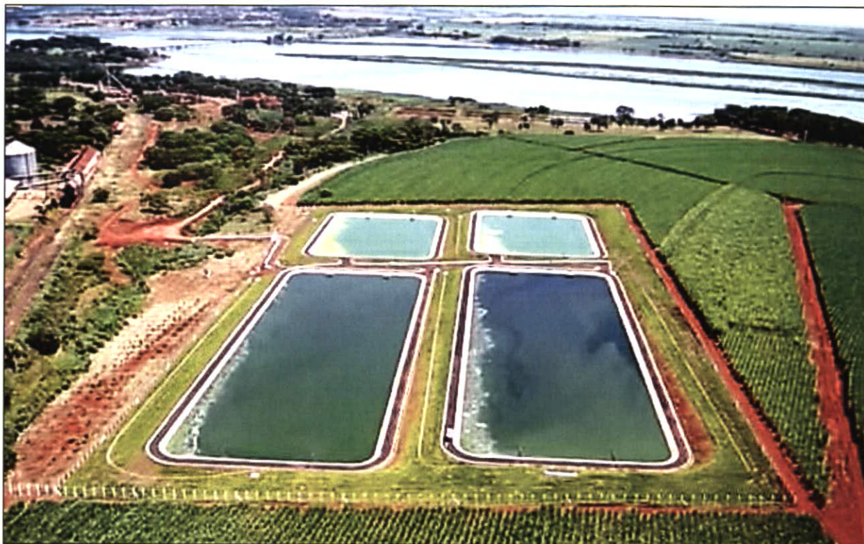
Foto 22 - Vista aérea da estação de tratamento de esgoto - Colômbia
