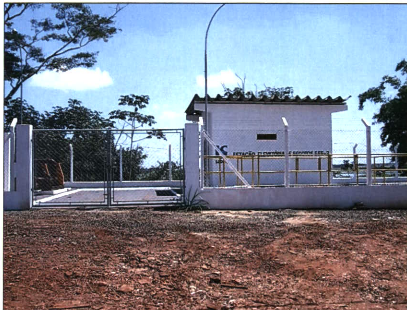
Foto 21 - Estação elevatória EEE02
