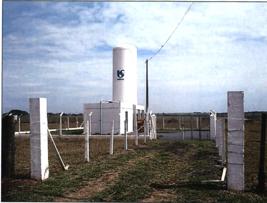
Foto 15 - Reservatório Elevado T01 - Colômbia
