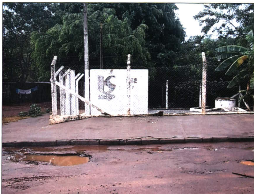
Foto 20 - Estação elevatória EEE 01
