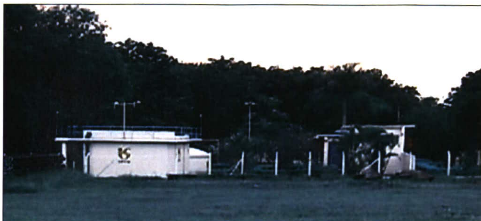
Foto 5 - Vista geral da estação de tratamento de água
