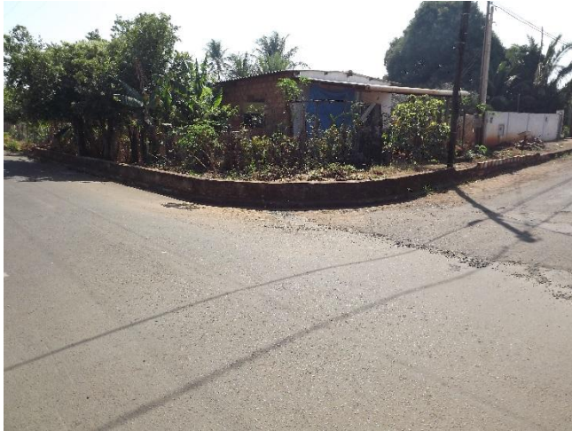
Foto 3.1 – Local do ponto crítico em que há alagamento e detalhe do alteamento da guia no passeio público como medida para evitar a entrada de água pluvial na residência
