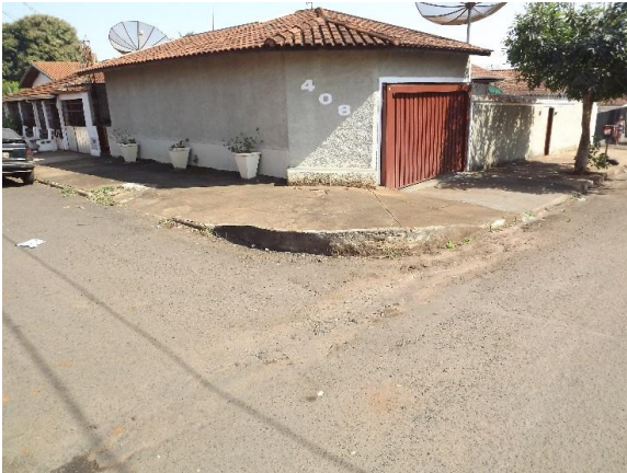
Foto 3.5 – Ponto crítico com alteamento de guia como medida paliativa aos efeitos negativos do alagamento
